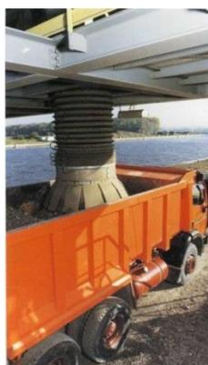
Рисунок 2.60 — Система разгрузки силоса клинкера с стержневыми и секторными затворами и погрузка в автотранспорт
